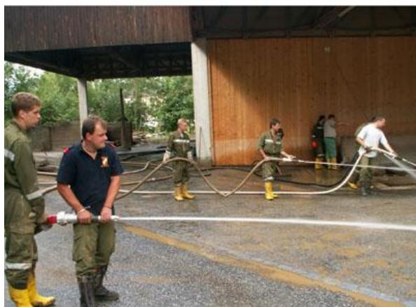
Der mit unzähligen Schaufeln, Besen, Krampen, Schiebetruhen, Eimern, B und C-Druckschläuchen, Notstromaggregat und Unterwasserpumpen bestückte Anhänger ist für solche Einsätze bestens geeignet, da man fast überall komplett autark Arbeiten kann und genügend Arbeitsgeräte für solche Aufräumungsarbeiten zur Verfügung stehen.
