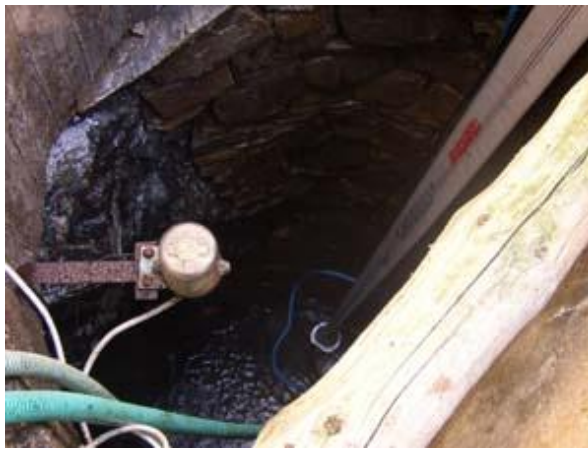
Auspumpen und Reinigen eines Hausbrunnens.
