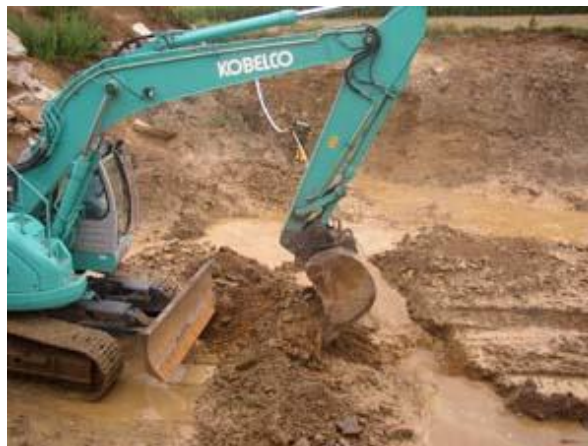
Ein Bagger grub einen Graben damit das restliche Wasser zu den Pumpen gelangte.
